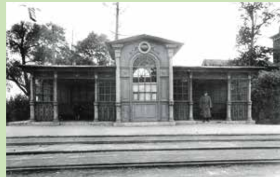
Остановочный павильон станции Петровское-Разумовское
